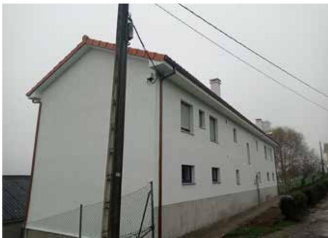
Las obras consistieron en la retirada de toda la teja de cubierta, canalones y bajantes así como de la carpintería exterior de la planta baja del edificio para a continuación corregir las irregularidades del tablero de cubierta, colocar una lámina impermeable y nueva teja cerámica mixta. También se realizó el enfoscado de las dos chimeneas y se instalaron nuevos canalones y bajantes.
