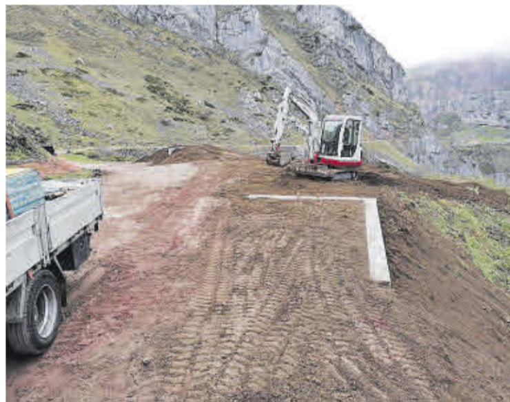
Obras en el alto de La Farrapona para instalar el mirador.
